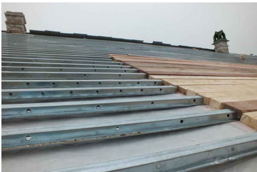
Фотография 2. Устройство металлической обрешетки
