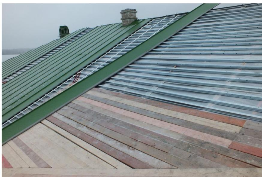
Фотография 3. Покрытие кровли крашеным металлом
